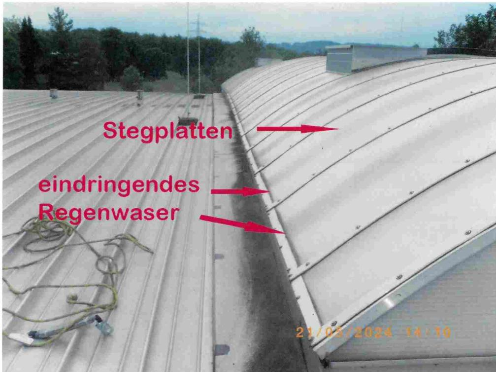
Im Vorfeld hat eine Begehung mit einer Fachfirma und den Hersteller der Stegplatten gegeben. Da die passenden Stegplatten noch hergestellt werden, ist eine komplette Erneuerung der Lichtbänder nicht notwendig.
