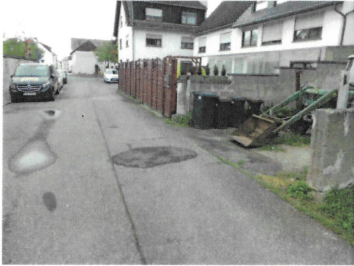
Abb. 3: Einseitiger Tiefbordstein an Grundstücksgrenze
