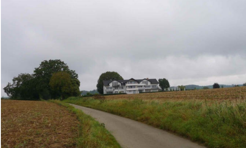
Abbildung 10: Blick auf den Wendelinushof vom Zufahrtsweg aus Richtung Süd
