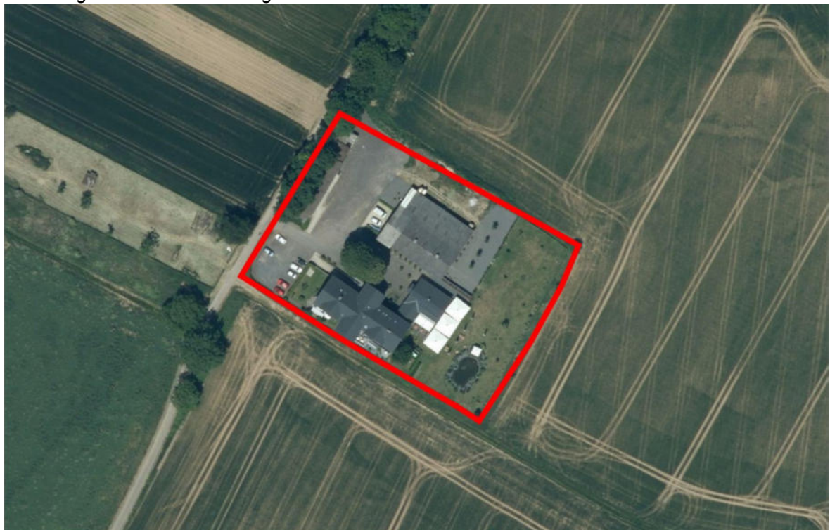
Abbildung 2: Luftbild des Plangebiets
